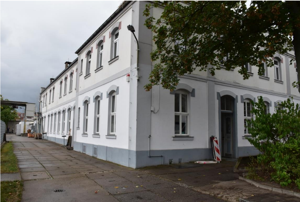
Das Hauptgebäude Industriestraße 17: Hier befindet sich auch die Disposition des Möbeldienstes. Am Haus vorbei geht es zum Sozialen Kaufhaus und zur Spendenannahme. Foto: C. Trache
