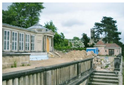
Der Förderverein Lingnerschloss e. V. möchte die Zusammenarbeit mit dem SUFW nicht missen. Bereits seit 7 Jahren schaffen die Teilnehmer aus Beschäftigungsmaßnahmen die Grundlage für die Restaurierung des Schlosses.
