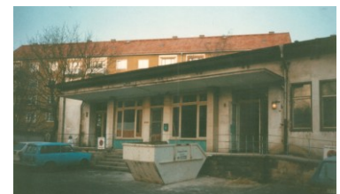
Objekt Jakobsgasse erste große Komplexbaustelle für Hochbaufachwerker, Bau- und Metallmaler.
